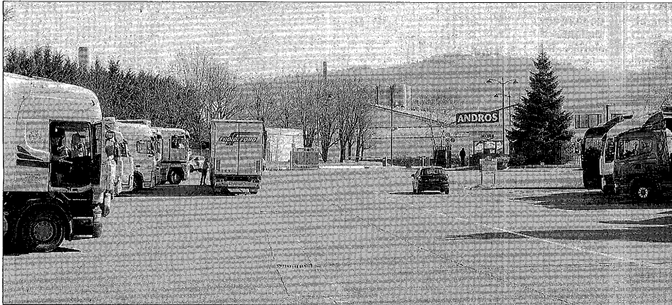
AMÉNAGEMENTS. La zone industrielle de Biars, qu'Andros occupe à 50 %, est en cours de requalification pour devenir zone d'intérêt régional. Elle devrait être désenclavée à l'horizon 2015. PHOTO PASCAL FERROUIN
